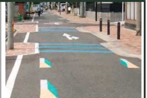
- 협착부 협착부는 차량통행부분의 폭을 물리적으로 좁게 하거나 시각적으로 좁아보이게 하여 차량의 속도를 유지
