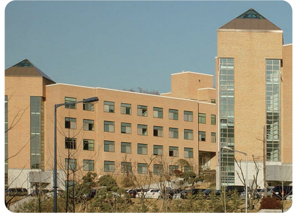
● 발주처 : 단국대학교 시공사 : 금호건설(주) 현장명 : 단국대 용인캠퍼스 건설공사
