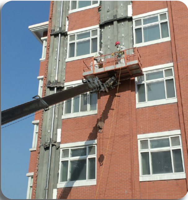
- 조적벽체 전부를 제거 후 재 시공 -
