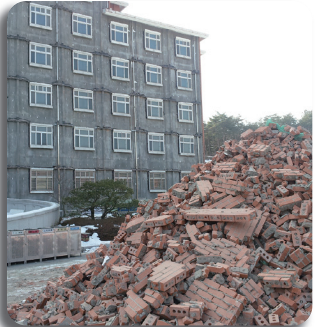
- 조적벽체 전부를 제거 후 재 시공 -
