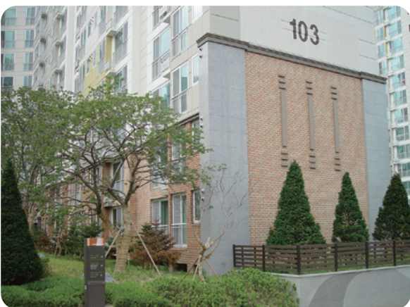
● 발주처 : SH공사 시공사 : 태영건설 현장명 : 신내 2지구
