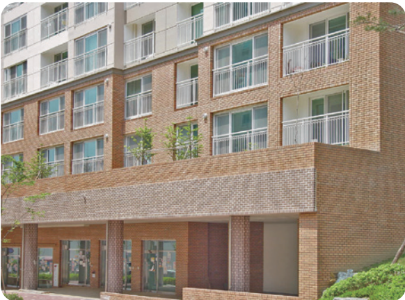
● 발주처 : SH공사 시공사 : 두산건설 현장명 : 은평 뉴타운
