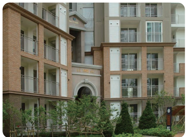
● 발주처 : 인천도시개발공사 시공사 : 신동아건설 현장명 : 논현택지개발지구
