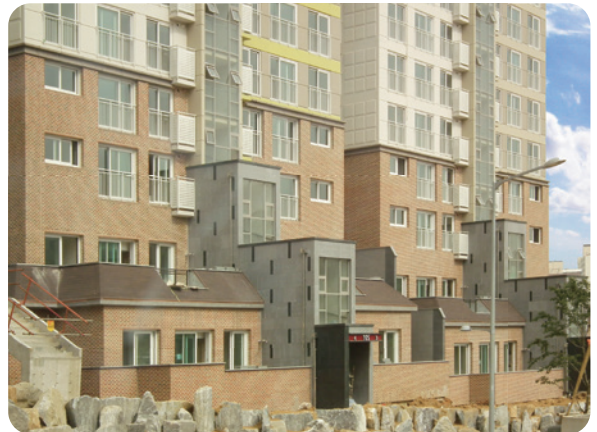
● 발주처 : SH공사 시공사 : 풍림산업 현장명 : 천왕택지개발지구
