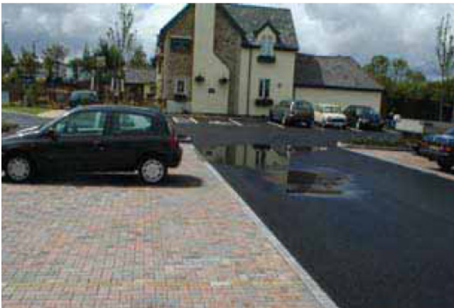
투수블록 포장(좌), 불투수 아스팔트 포장(우)
