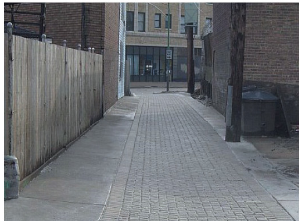
시카고 Green Alley Program (투수 블록 포장 전, 후)
