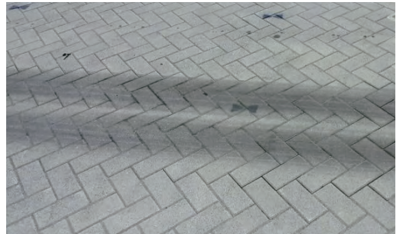
대일텍 3D-HOLE블록 시공사진
