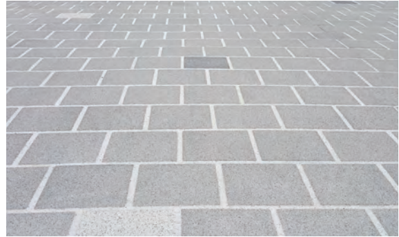
대일텍 3D-HOLE블록 시공사진
