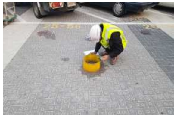
현장 침투능 시험 전경
