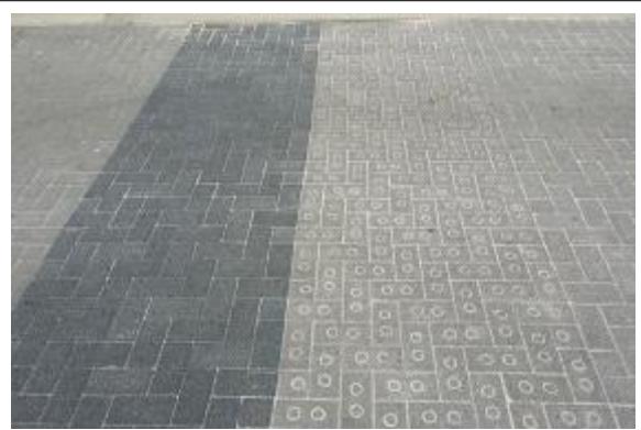
서울시 송파구 풍성로 23길 내 이면도로 차도용 투수블록
