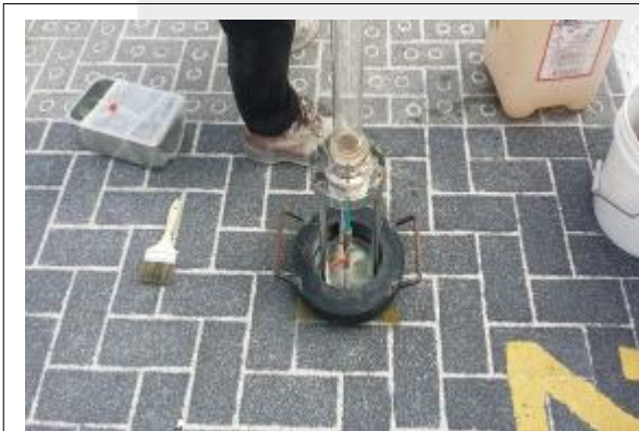
현장 투수량 시험 전경
