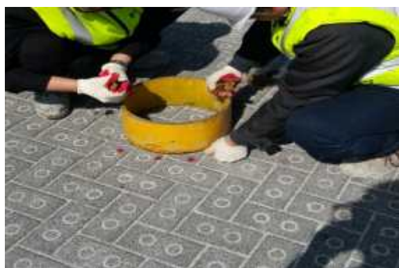
현장 침투능 시험 전경
