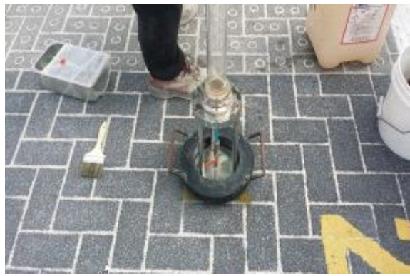
현장 투수량 시험 전경
