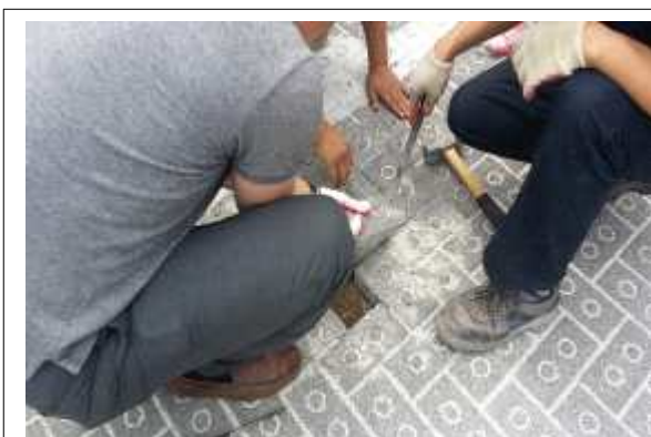
투수블록 현장 채취 전경
