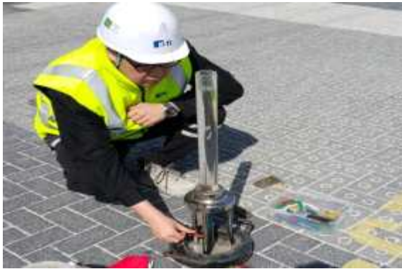
현장 투수량 시험 전경
