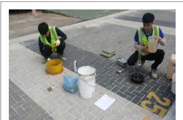
1차 현장추적조사 전경
